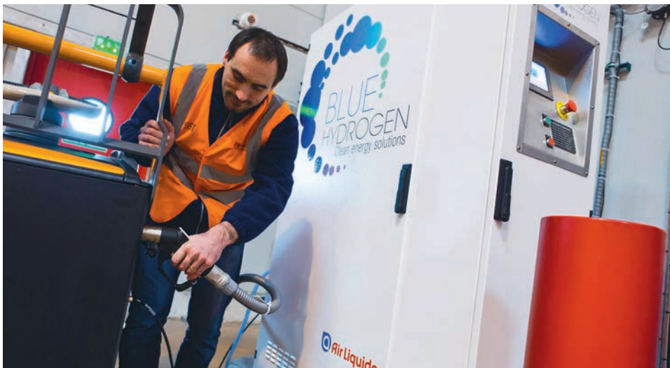
Stacja tankowania wodoru w Prelocentre w Saint-Cyr-en-Val dostarcza wodoru do ponad 60 wózków widłowych.
